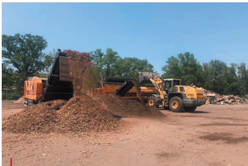
Les déchets verts sont broyés puis placés en andains pour préparer le compost.
